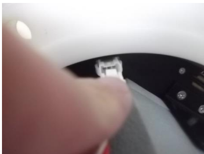
Photo.10 バッテリーコネクターの装着中
