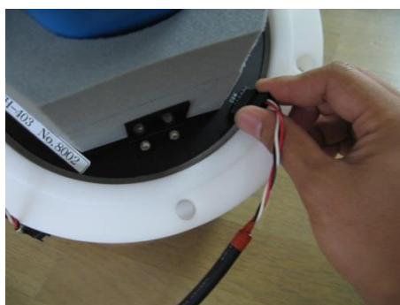
Photo.20 パソコン接続ケーブルを接続する
