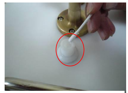
Photo.4 綿棒で内部の付着物や砂などを取り除きます
