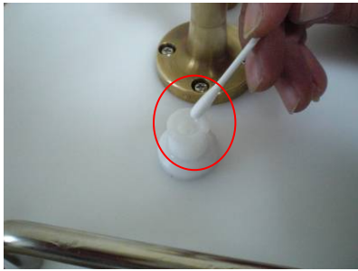
Photo.4 綿棒で内部の付着物や砂などを取り除いてください。
