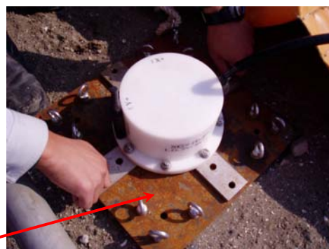
Photo.25 クロス板取り付け
