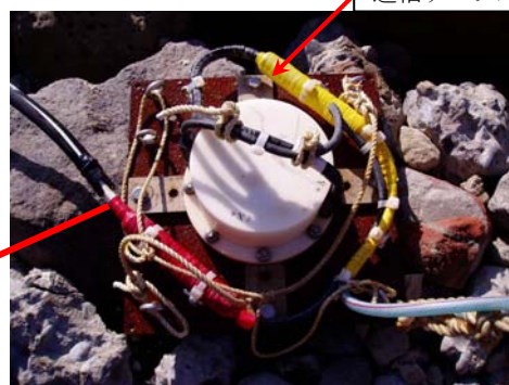
Photo.26 装置設置前状況
