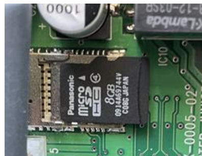
Photo3.6 SDカード取外し状態
