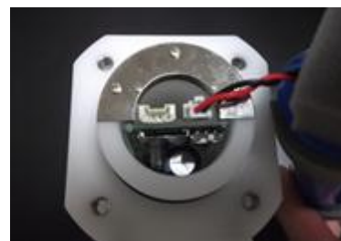
Photo3.7 リチウムバッテリーの取付け状態確認
